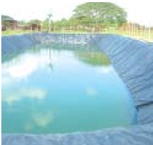
Figura 3: Balsa reguladora o reservorio para agua. UG – Vinces. 2010.
