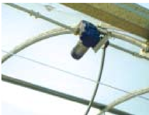
Figura 3: Parte interna de un túnel del invernadero de alta tecnología con su motor para abrir y cerrar la ventana. U.G. Vinces. 2010.
