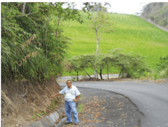
Foto 3. Estribo derecho de la Presa Daule-Peripa apoyado en cangagua de la Formación Balzar, señalada por el autor.
