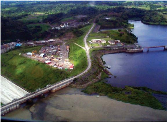
**Foto 1.** Presa Daule-Peripa. Foto aérea tomada desde aguas arriba. A la izquierda vertedor en operación y a la derecha vista del embalse, torre de toma y área administrativa. Central en construcción 1998.
