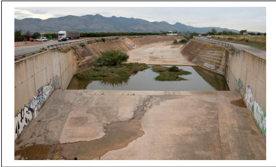
Figura 17. Canalización con muros de gaviones
