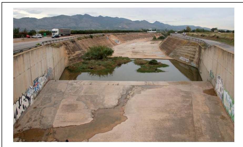
Figura 16. Canalización de hormigón (río Seco, Castellón)
