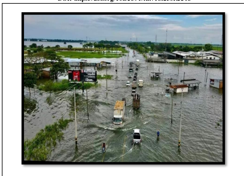
Figura 5. Inundación por encima de la vía e - 25
