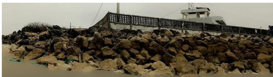
Figura 9 b Desplazamiento de Unidades de la armadura Autores
