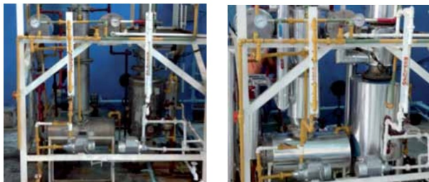
Figura 4. Columnas de destilación antes y después del aislamiento. Junio 2013
