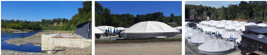
Figura 1. Zona de toma de agua del río de la planta 1 y piscinas de crianza de salmones.
