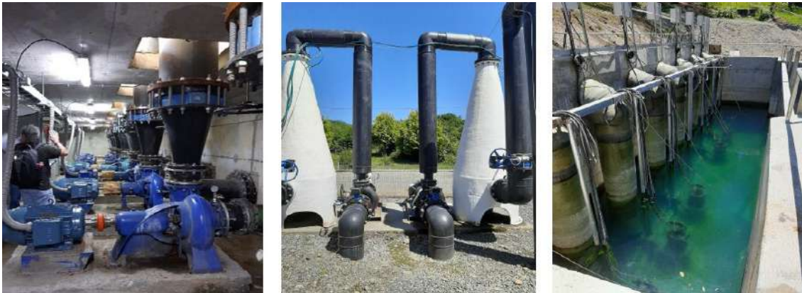
Figura 4. (a) Sala de bombas principales planta 1. (b) Bombas y conos de oxigenación planta 1. (c) Bombas principales planta 2 (sumergibles).
