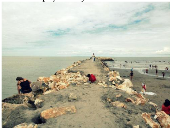
Fotografía 14. Muro de Contención
