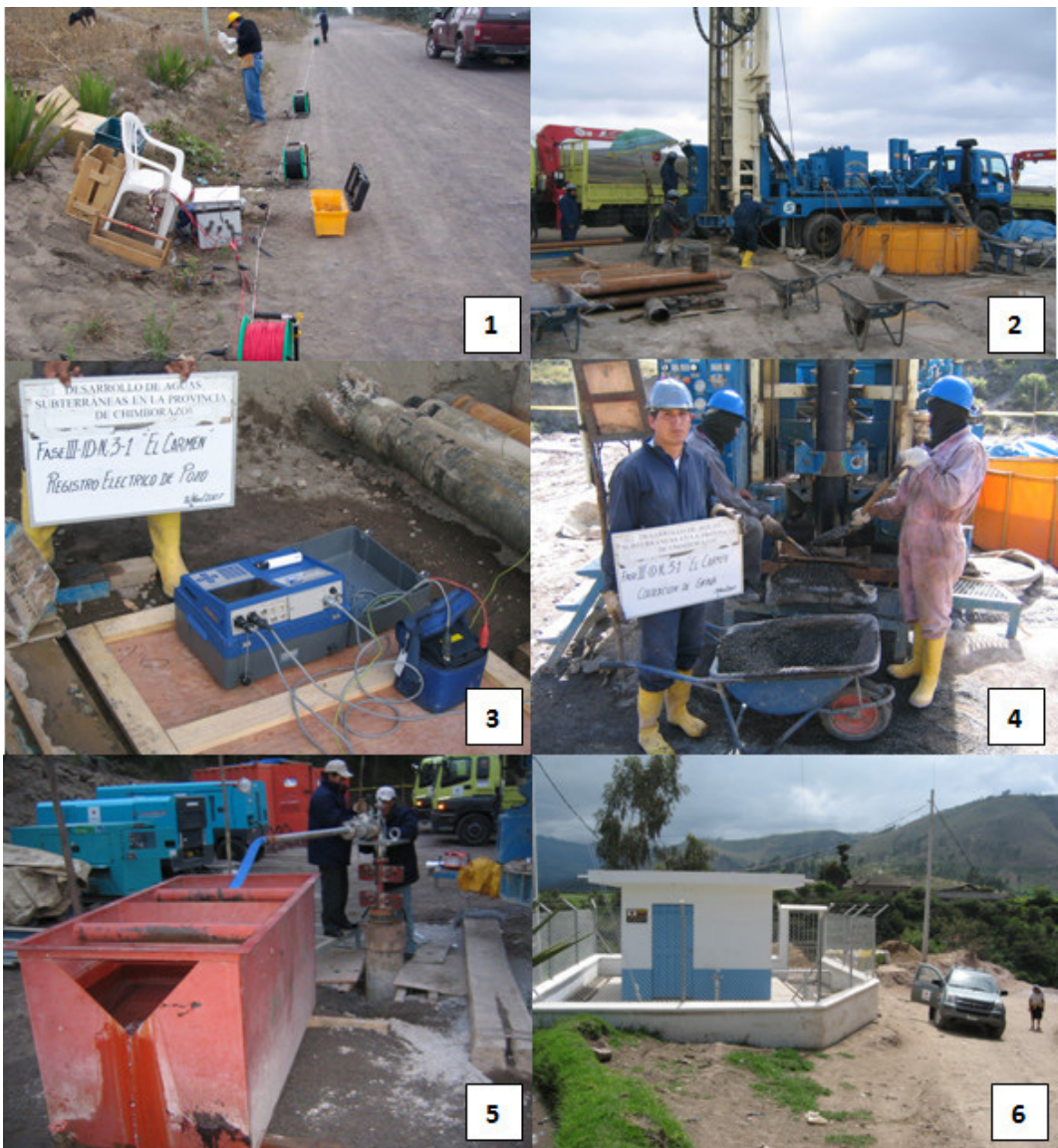
Figura 1 Secuencia cronológica de actividades ejecutadas durante el Proyecto de desarrollo de aguas Subterráneas incluidos equipos, herramientas y suministros asociados; 1) Equipos para prospección geofísica de superficie mediante métodos eléctricos, 2) Equipos y suministros de perforación de pozos profundos, 3) Equipo para registro y diseño de pozo, 4) equipos y herramientas para entubado de pozo y construcción de sello sanitario, 5) equipos y herramientas para pruebas de bombeo, 6) construcción de estación de bombeo, instalación de paneles eléctricos equipo de bombeo y tendido de líneas de impulsión.
