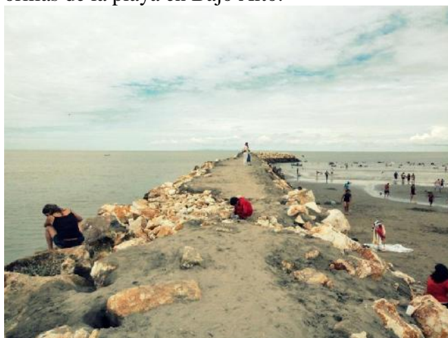
Fotografía 14. Muro de Contención
