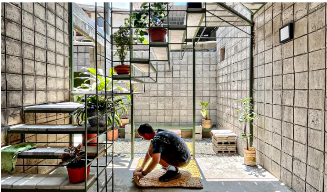
Figura 13: Interior de vivienda con estructura metálica, bloques de hormigón y patio de luz.
