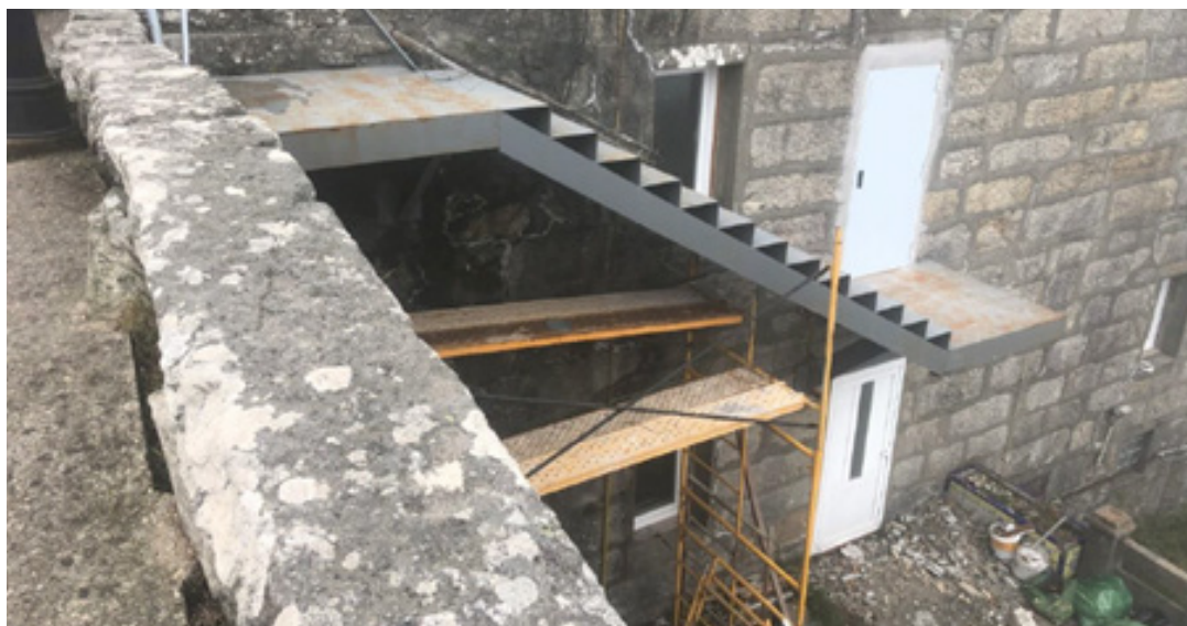
Figura 15: Tomado De Informe Evaluación - Arqueóloga Rosa Quintero. Fachada Sur Con Escalera De Emergencia En Obras. (2025)
