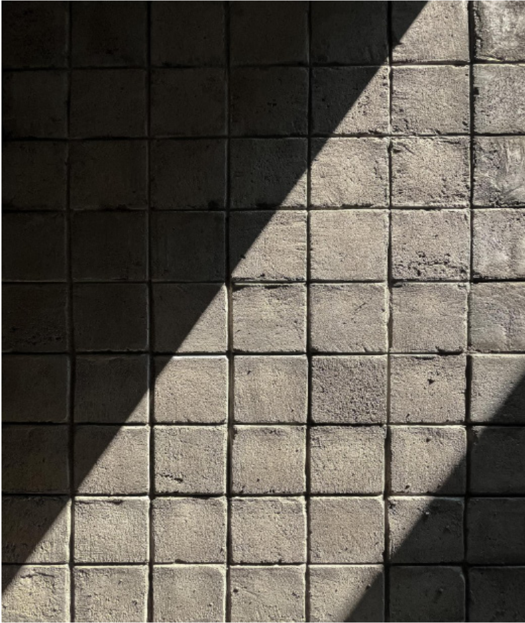
Figura 16: Detalle de muro de bloques de hormigón con incidencia de luz natural.
