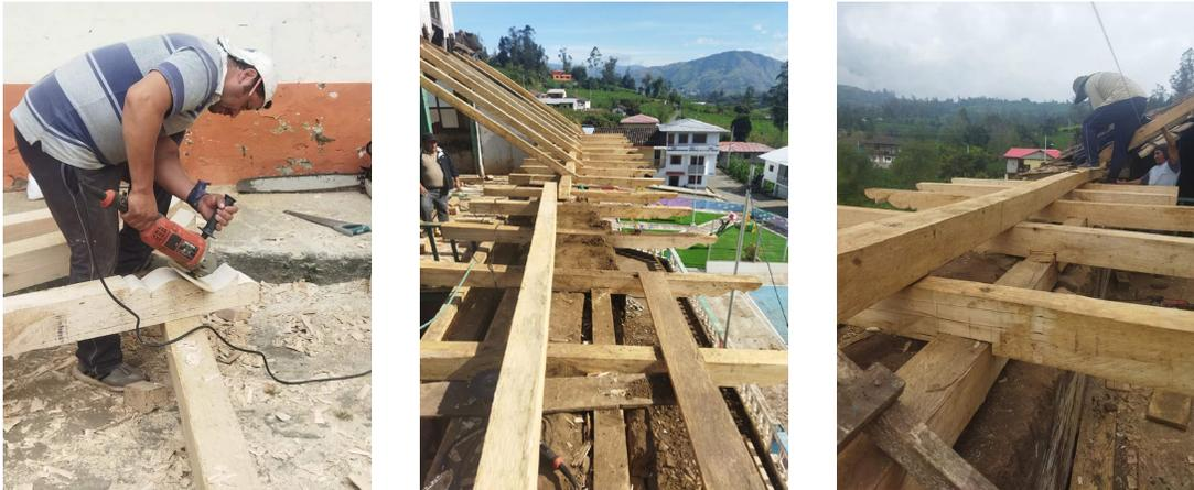
Figura 5: Detalle Constructivo Vigas Cargadoras y Canecillo. (2024)
